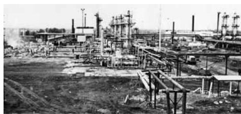
Строительство установки комплексной подготовки газа № 2. 1971 год
