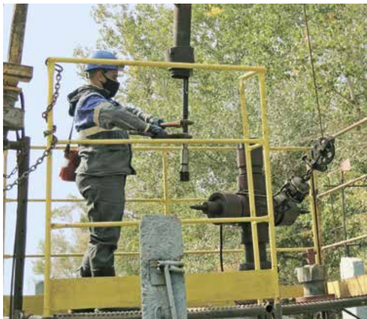
Монтаж прибора фотовидеофиксации при испытании на скважине № 727 установки комплексной подготовки газа № 1. 2021 год
