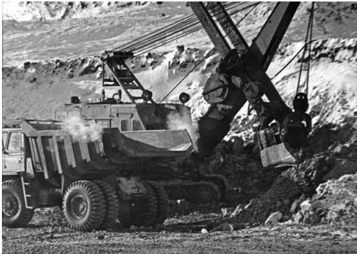
Выемка грунта на очистных сооружениях газавода. 1973 год
