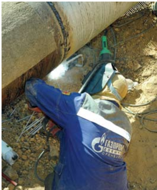
Выполняются огневые работы
