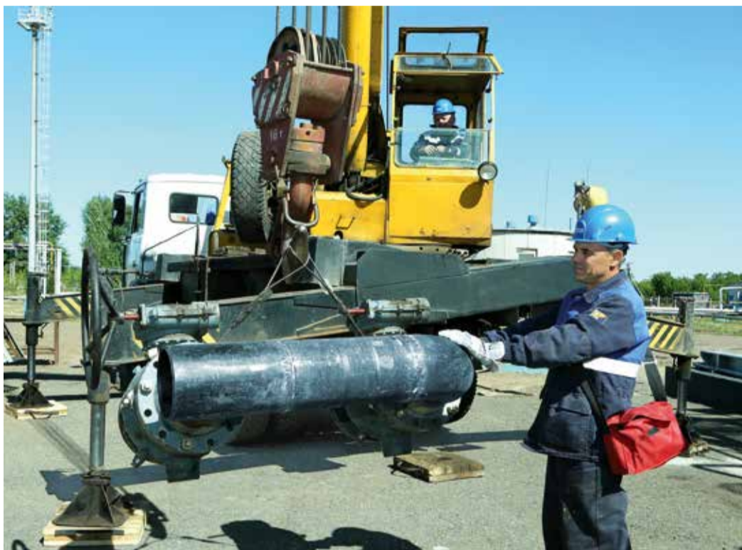
Выполняется подача трубного узла к месту монтажа
