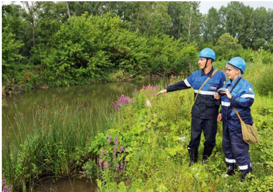
Инженер службы диагностики и технадзора Юлия Ефашкина и монтер ЛЭС № 2 Октябрьского ЛПУ Дмитрий Кудряшов осматривают место подводного перехода конденсатопровода через реку Ашкадар
