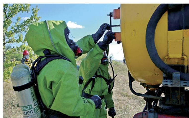
Оперативное отделение группы оперативного реагирования по ликвидации аварийных разливов военизированной части устанавливает герметизирующее устройство на место утечки опасного вещества из цистерны
