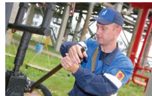
Оператор Алексей Кузнецов закачивает трансформаторное масло
