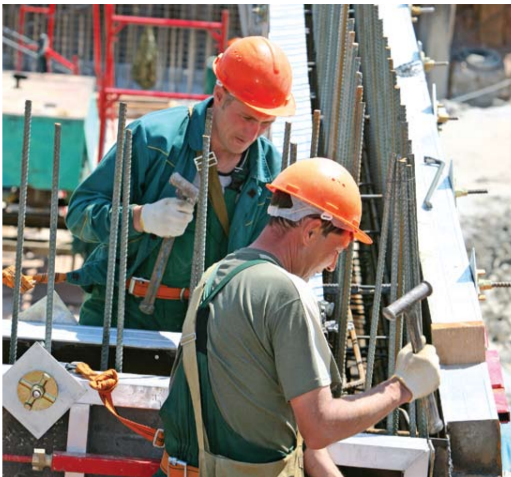
Ведется реконструкция очистных сооружений
