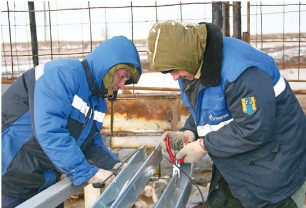
Электромонтеры бригады службы электроснабжения ГПУ Сергей Давыденко и Сергей Макаревский проводят монтаж кабельных лотков на скважине № 6010
