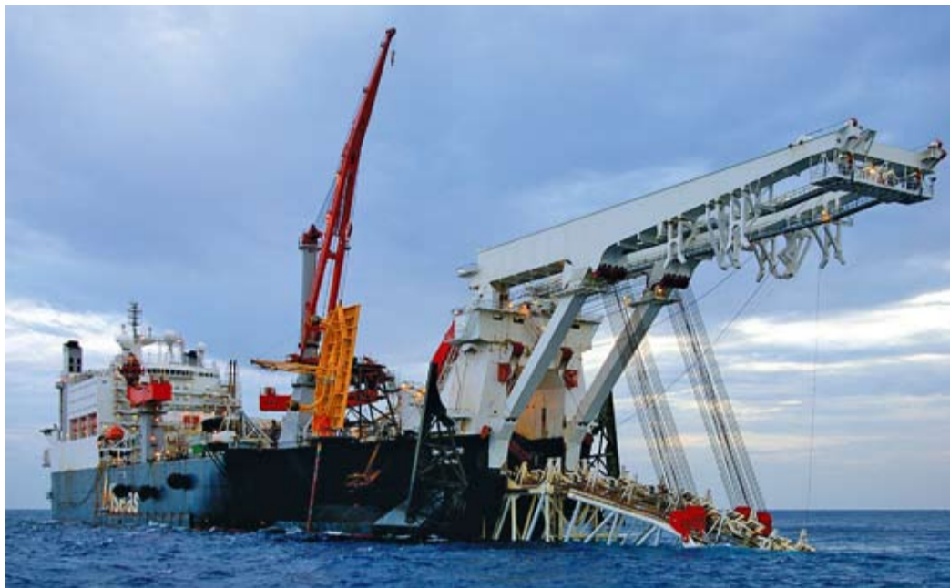
Строительство газопровода «Северный поток»
