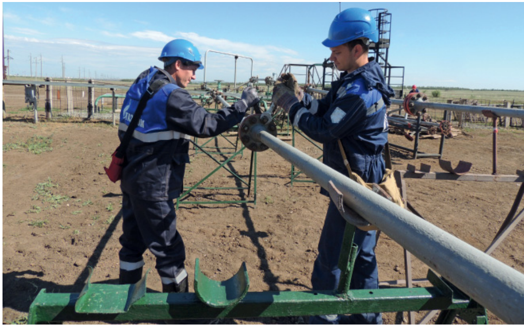
Андрей Симанов и Илья Кривошеев монтируют трубопровод подачи нефти от скважины к исследовательскому комплексу
