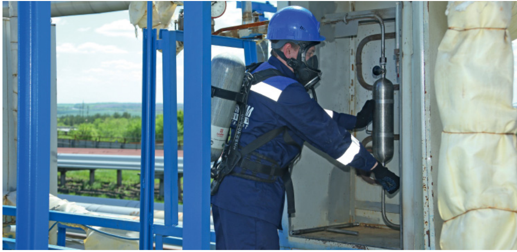
Установка пробоотборных шкафов и применение дыхательных аппаратов снизили влияние вредных факторов
