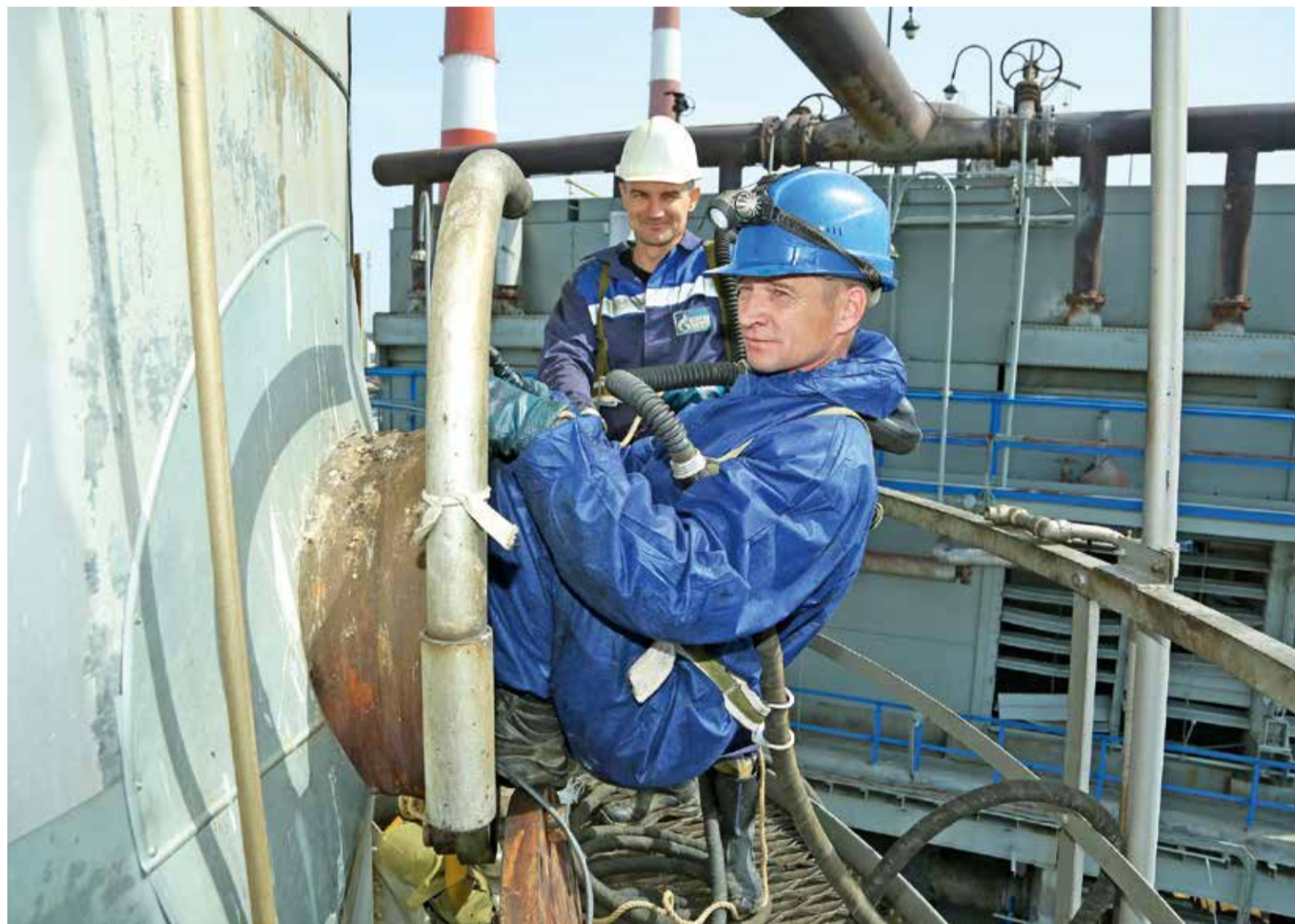
Сварщик Дмитрий Акашев готовится к проведению ремонта внутренних контактных устройств десорбера
