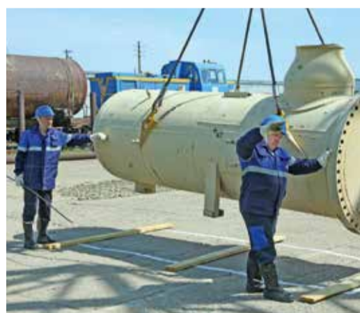
Слаженность имеет большое значение в работе стропальщиков
