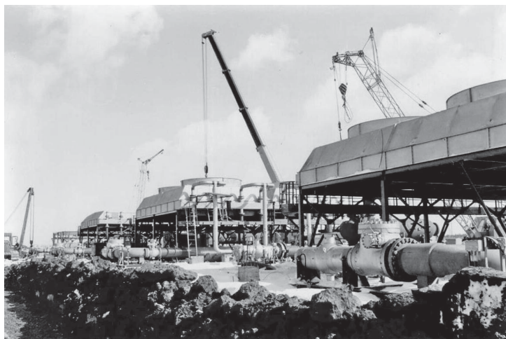
ДКС-2 на этапе строительства...
