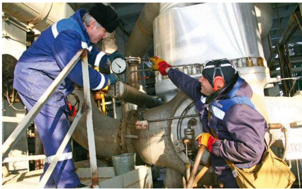
Операторы Сергей Колесников и Михаил Борцев обслуживают агрегат производства холода
