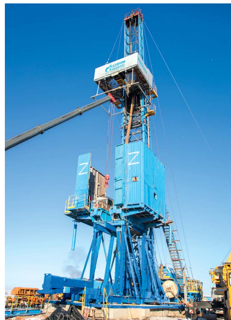
Большая часть оборудования на площадке — производства ООО «Уралмаш НТГО Холдинг» и других отечественных предприятий
