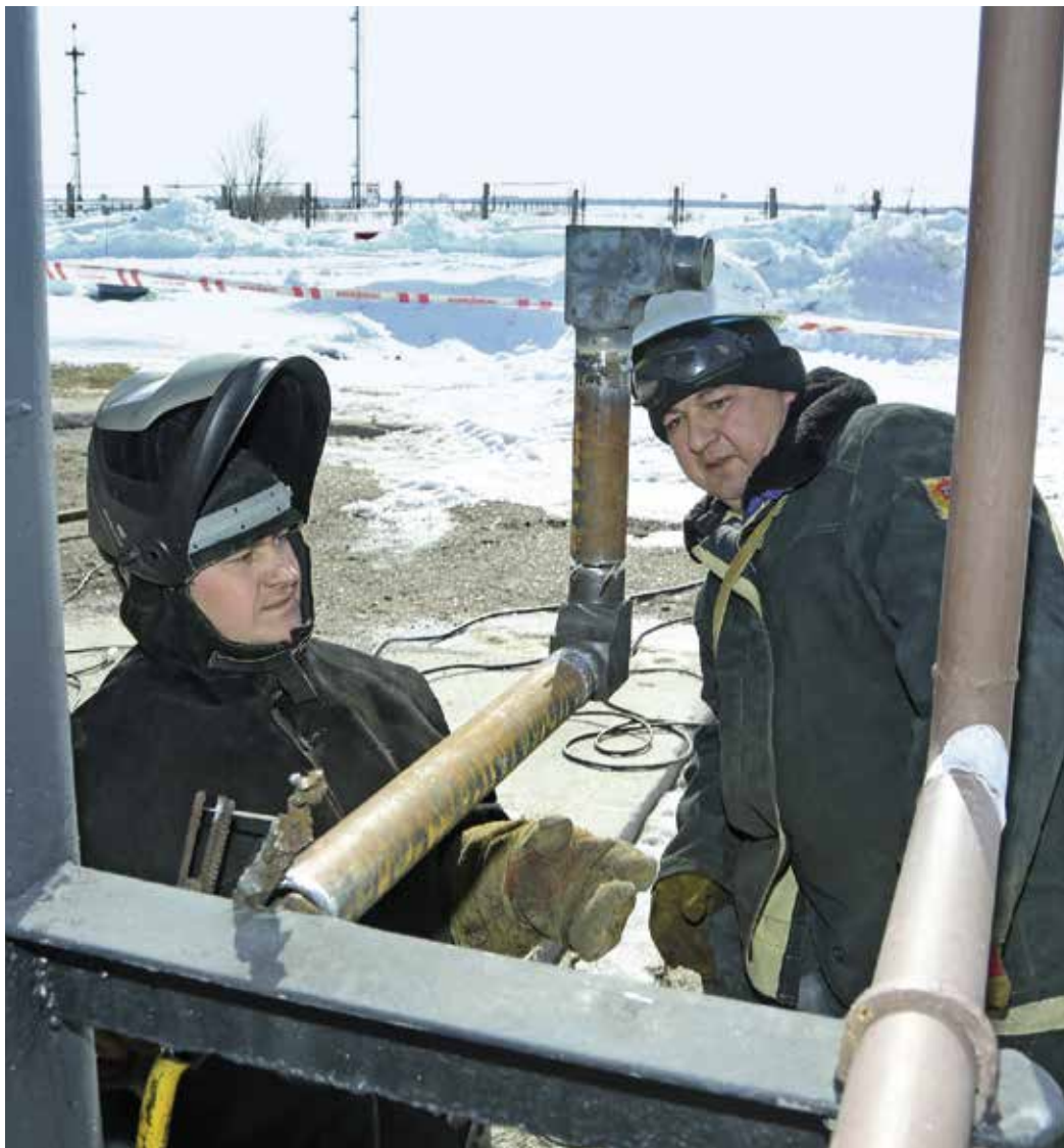
Сергей Мусс и Валерий Чекмарев монтируют дренажный трубопровод к емкости для хранения ингибитора
