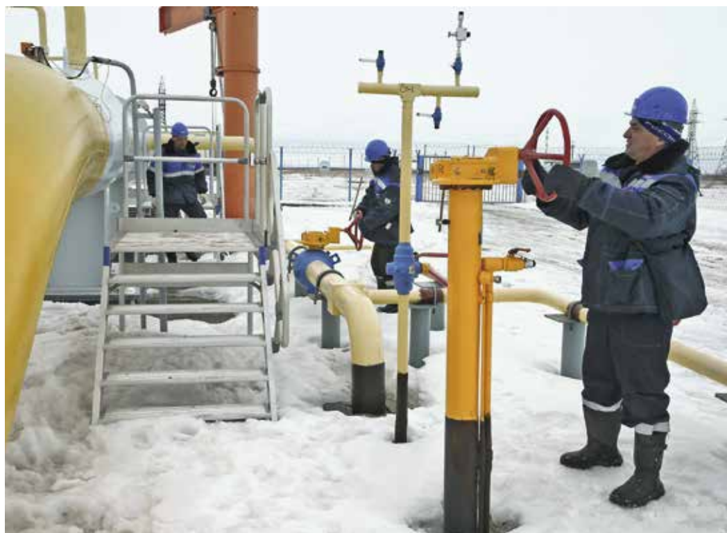
Трубопроводчики линейные Виталий Евлентьев, Олег Тимофеев, Александр Семёнов опробуют запорную арматуру на газопроводе-перемычке ДКС-1 — ДКС-2
