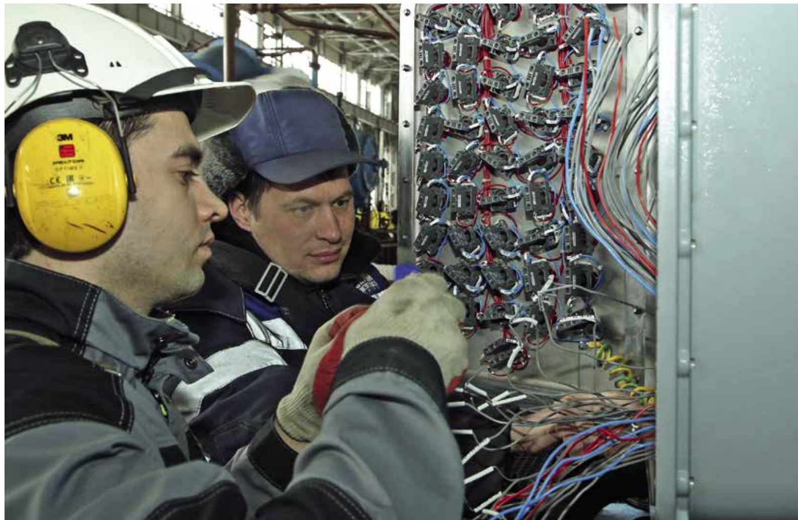
В машзале установки У-380 идет монтаж нового шкафа управления компрессором
