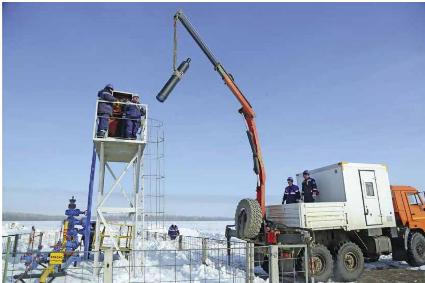
Бригада ОПС №3 монтирует баллоны, заправленные сжатым воздухом
