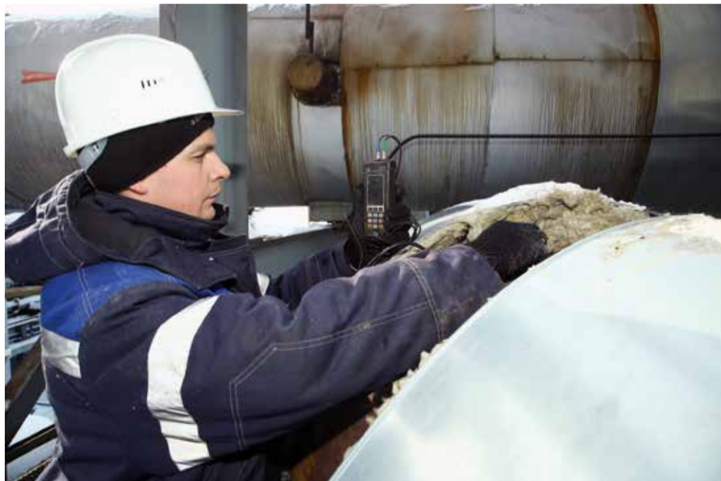
Дмитрий Петрищев обследует трубопроводы с помощью толщиномера, чтобы выявить поврежденные участки
