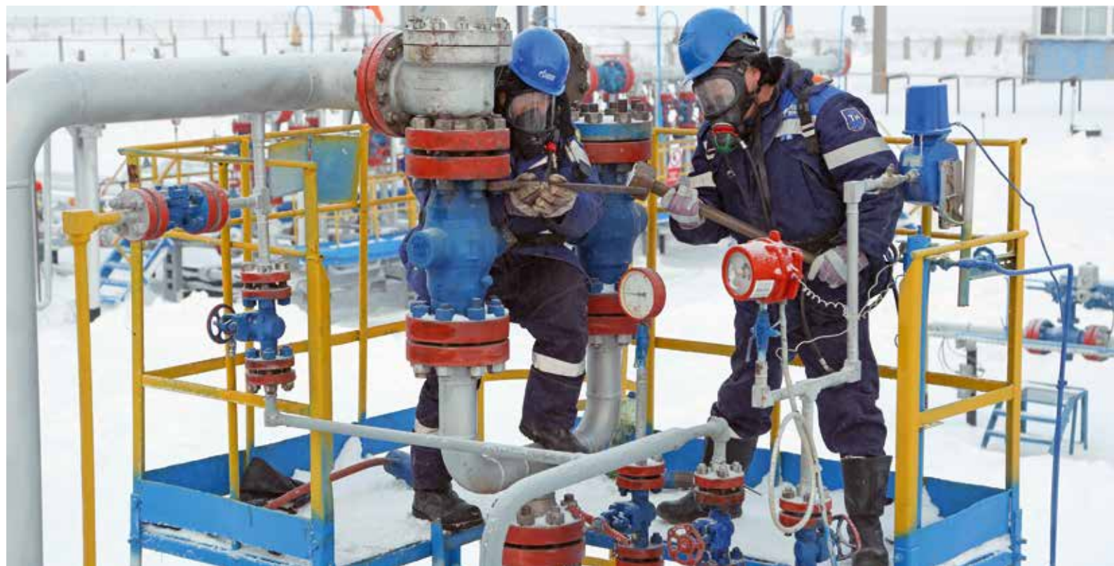
Операторы по добыче газа, конденсата и нефти Валерий Колесников и Юрий Лошкарев проводят газоопасные работы по замене предохранительных клапанов
