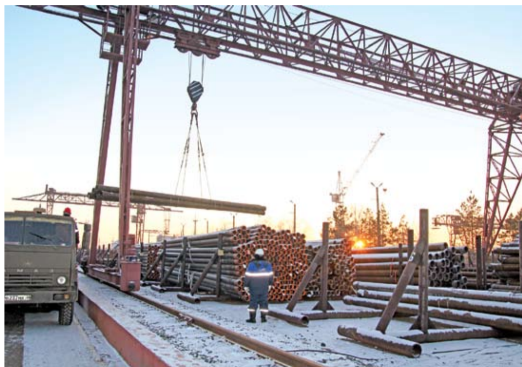
Мощности складского комплекса обеспечивают безопасное хранение больших объемов трубной продукции
