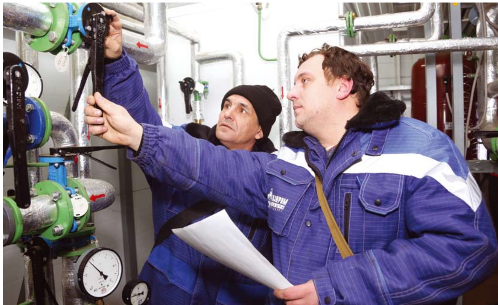
Новая котельная на УКПГ-12 – один из первых примеров реализации программы техпереворужения газопромыслового управления
