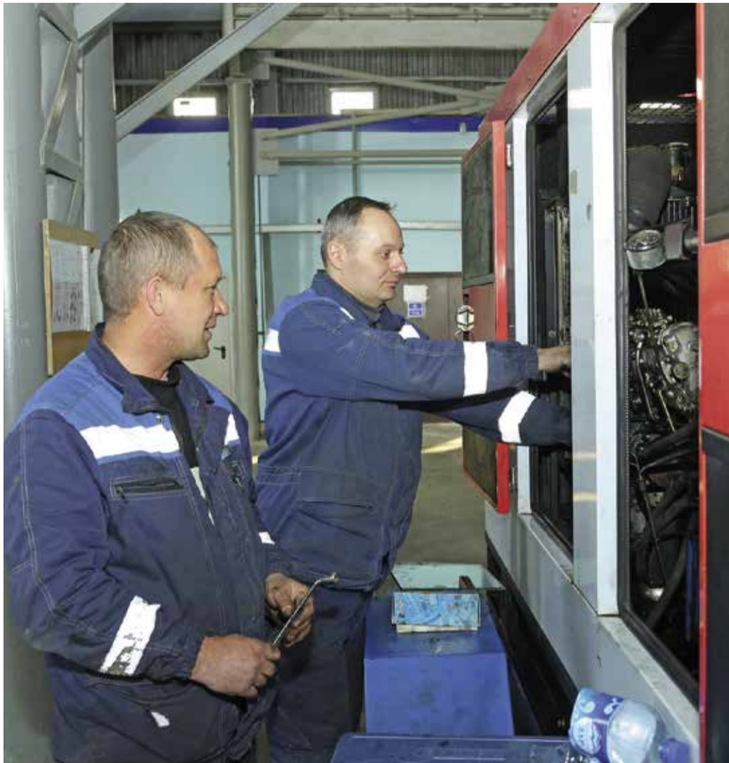
Андрей Николаенко и Николай Окунев ведут ремонт дизельной электростанции
