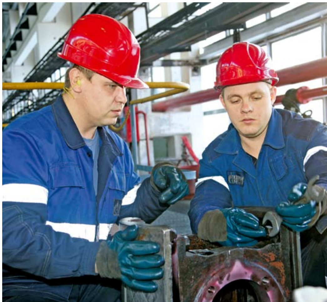
Молодежное звено Александра Тимакова ведет ремонт компрессора
