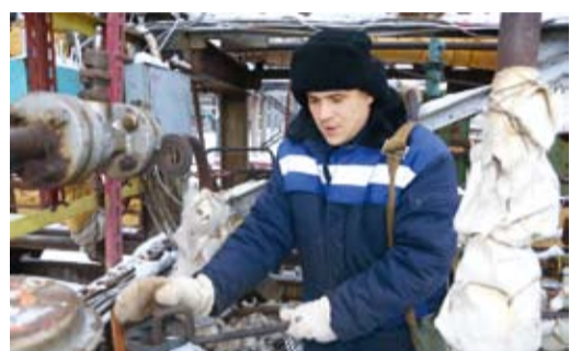
Проверка запорной арматуры
