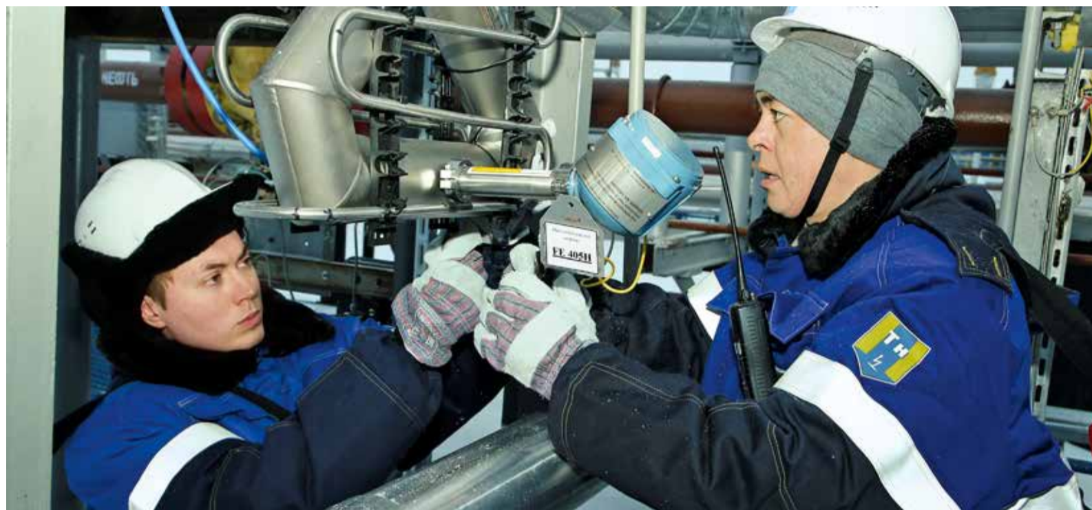
Операторы по добыче нефти и газа Дмитрий Ересковский (слева) и Валерий Хамидуллин монтируют змеевик массового расходомера
