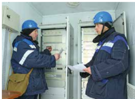
Техосмотр станции катодной защиты проводят монтеры электрохимзащиты Александр Слободсков (слева) и Юрий Бородин
