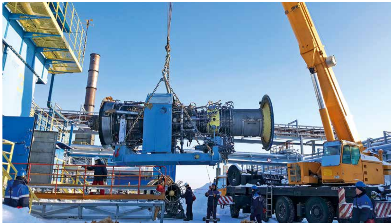
Ведется установка газотурбинного двигателя на рельсы, после чего его закатят в блок-бокс и опломбируют
