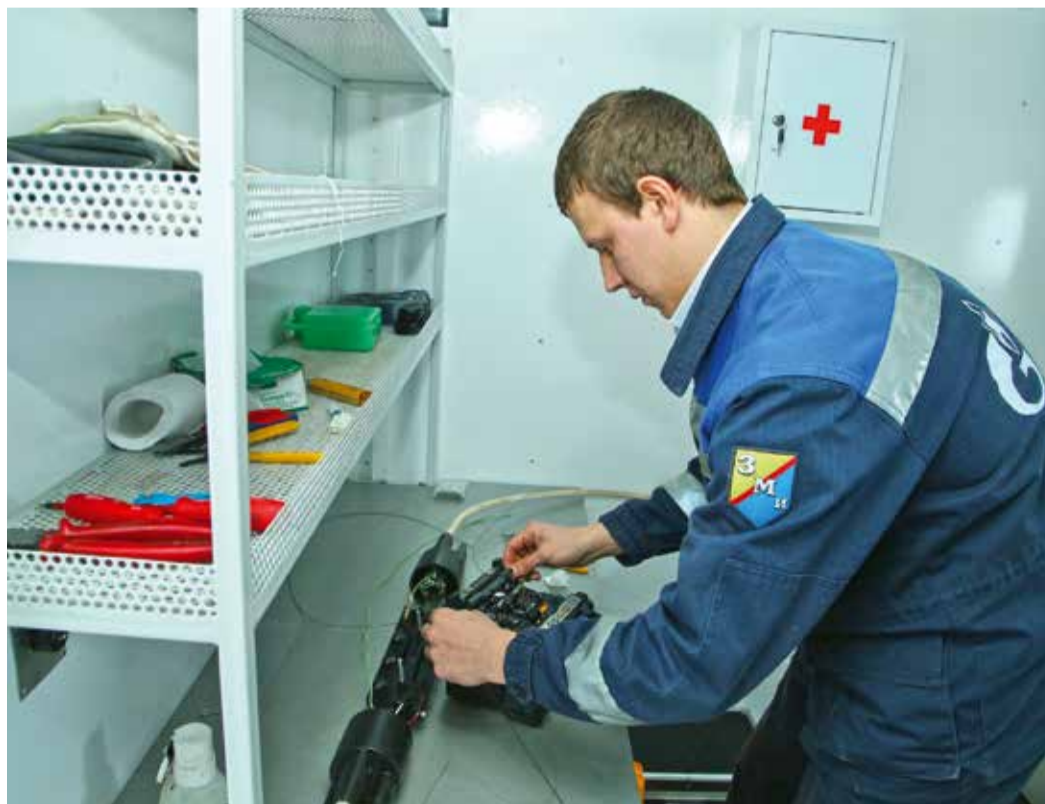
Электромеханик Дмитрий Скорняков показывает, как с помощью аппарата свариваются тончайшие нити оптоволоконного кабеля
