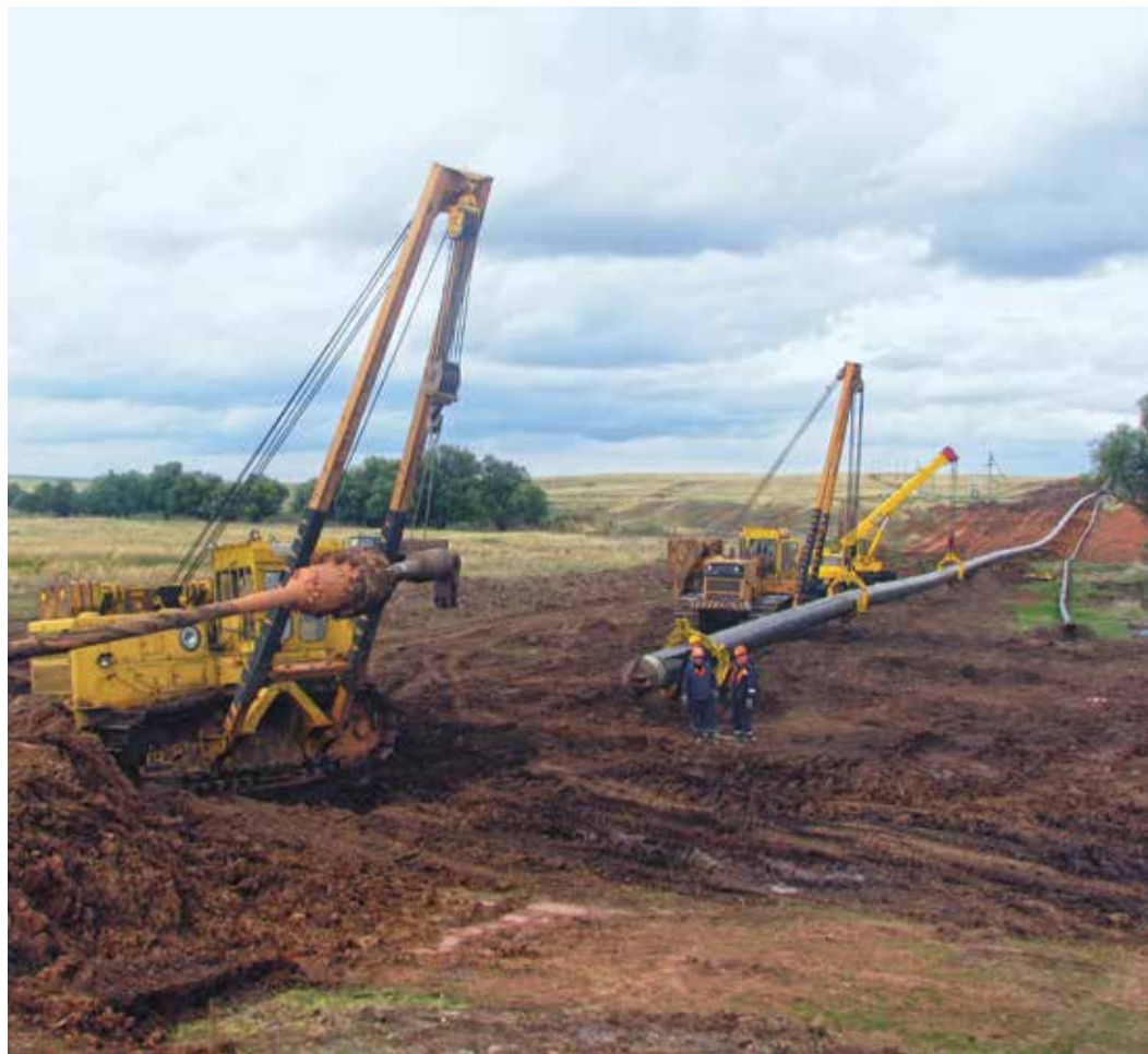
Ведется укладка трубопровода
