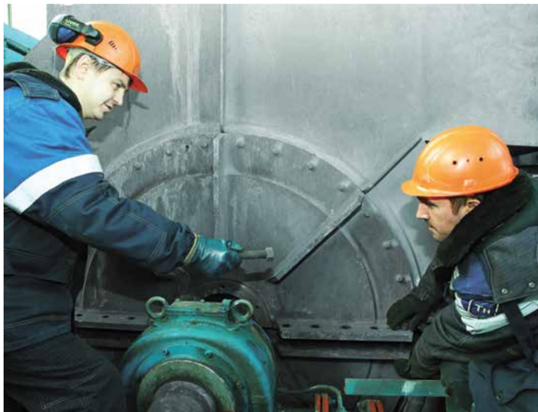
Слесари по ремонту технологических установок Олег Гуреев (слева) и Евгений Ласыгин ремонтируют воздухоувлажнитель.
