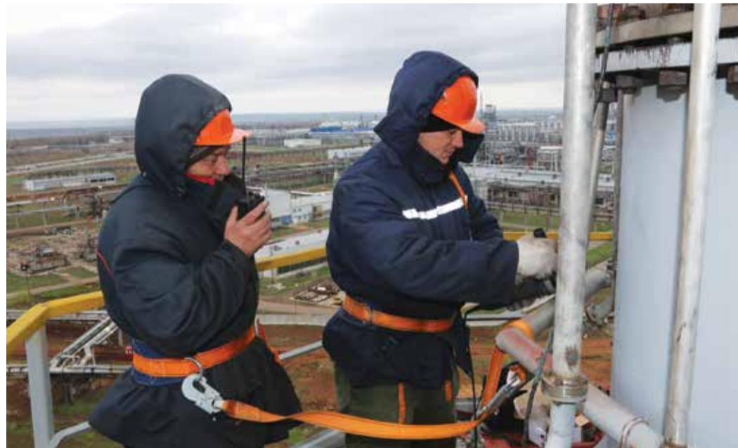
Монтажники осуществляют установку новых дежурных горелок
