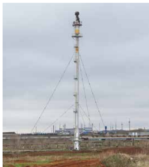
Работы проводятся на высоте 60 метров
