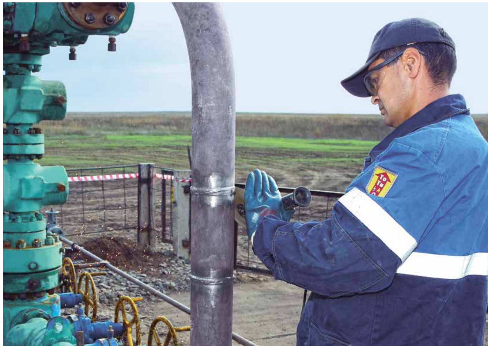
Слесарь Марат Ракишев защищает шов новой обвязки скважины
