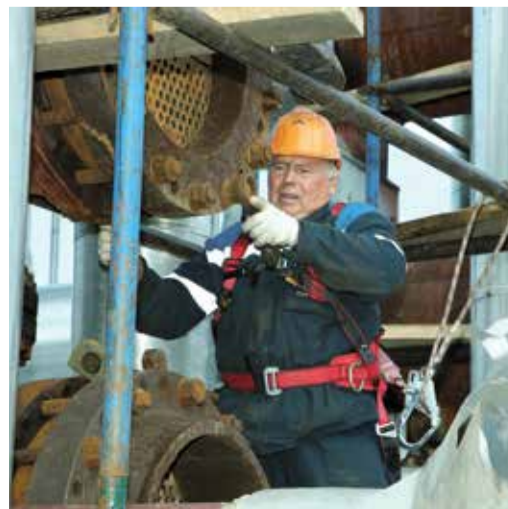
Ведутся работы на отделении № 510 установки № 25 гелиевого завода
