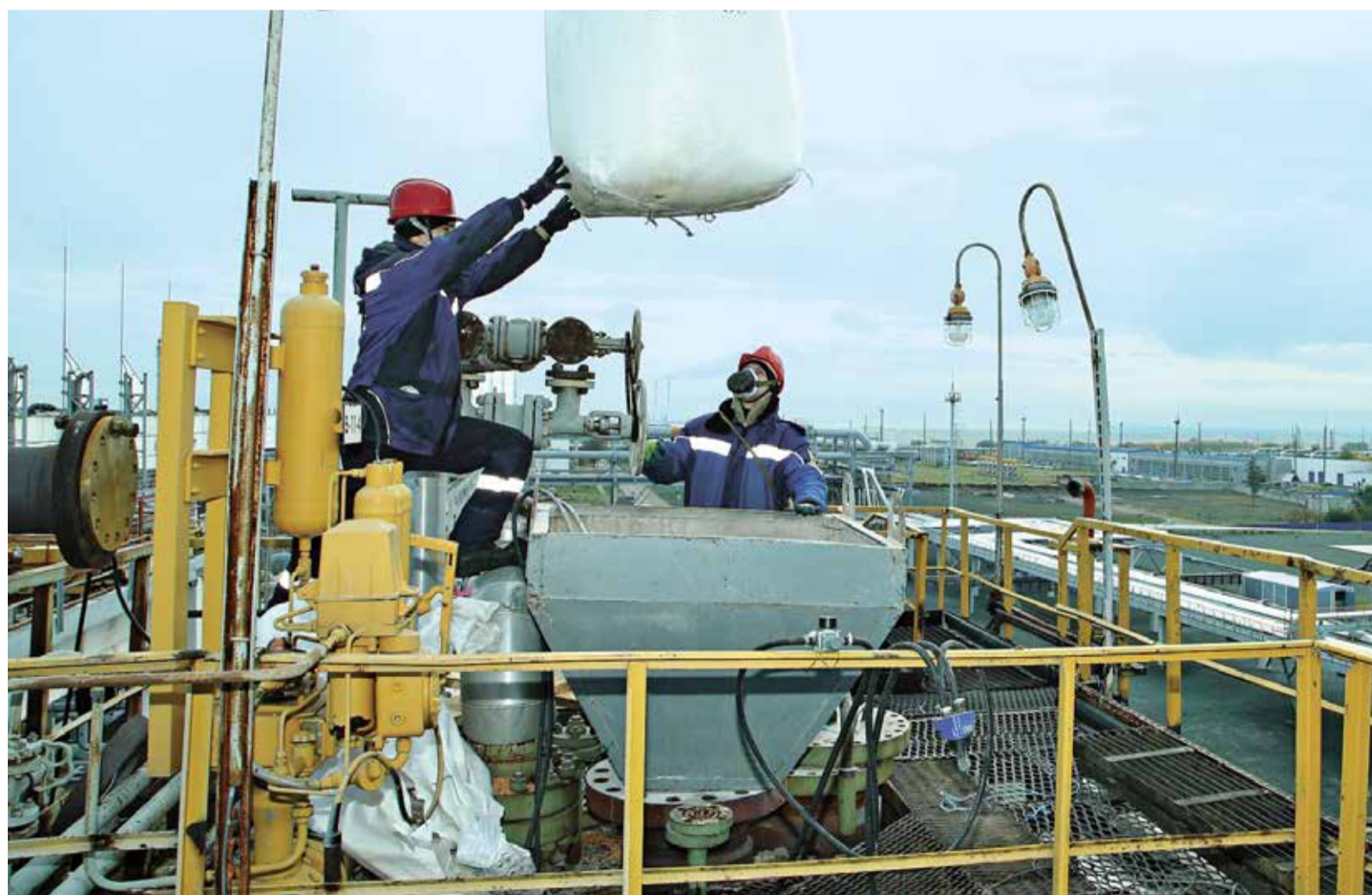
Операторы технологических установок Михаил Бибарцев и Егор Рейх ведут укладку цеолита по новой технологии
