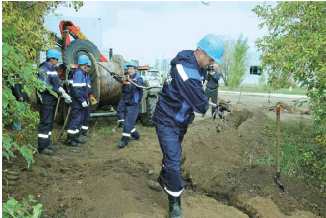
Ведется прокладка нового кабеля
