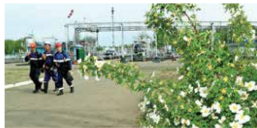
На площадке установки подготовки газа
