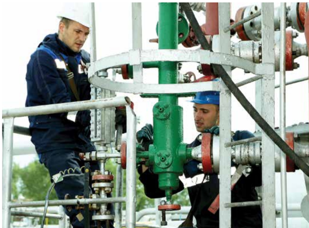
Идет ревизия оборудования второй технологической линии УКПГ-15
