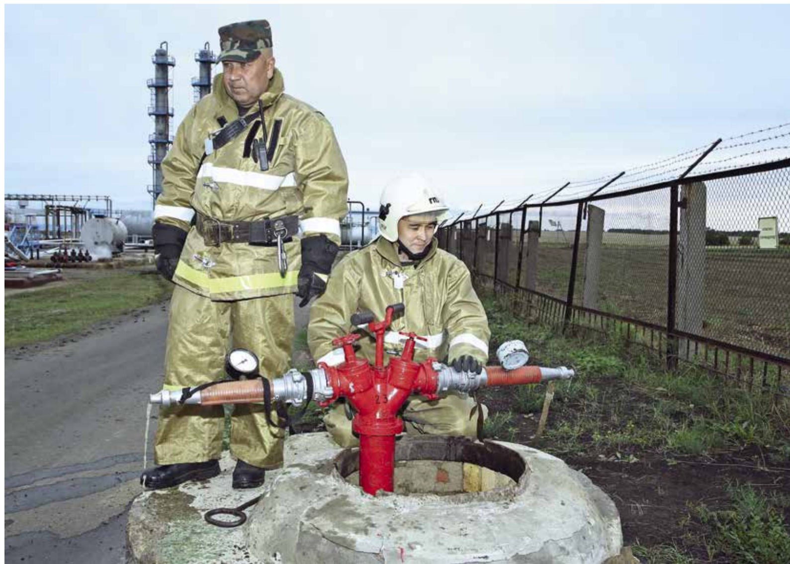
Пожарные ведут контроль давления воды, подаваемой на пожарный гидрант
