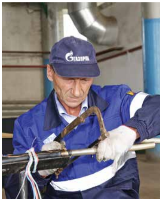
От работы кабельщика зависит качество связи
