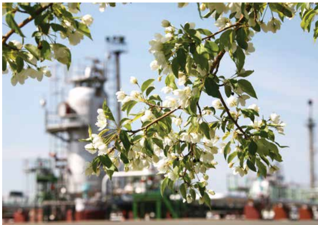
Весна на установке комплексной подготовки газа
