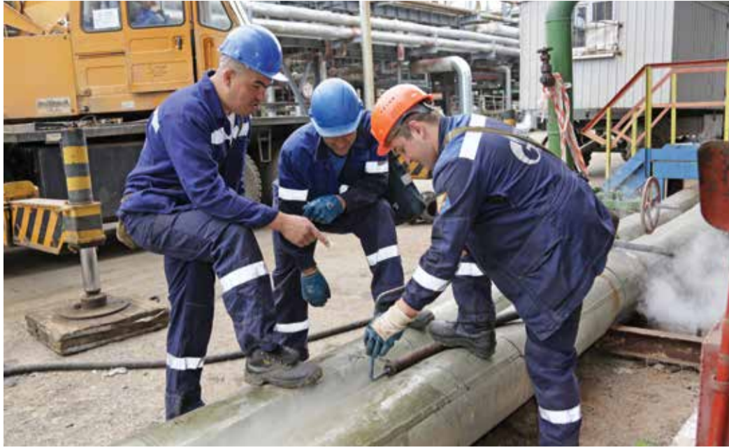
Ведется продувка импульсной линии насоса
