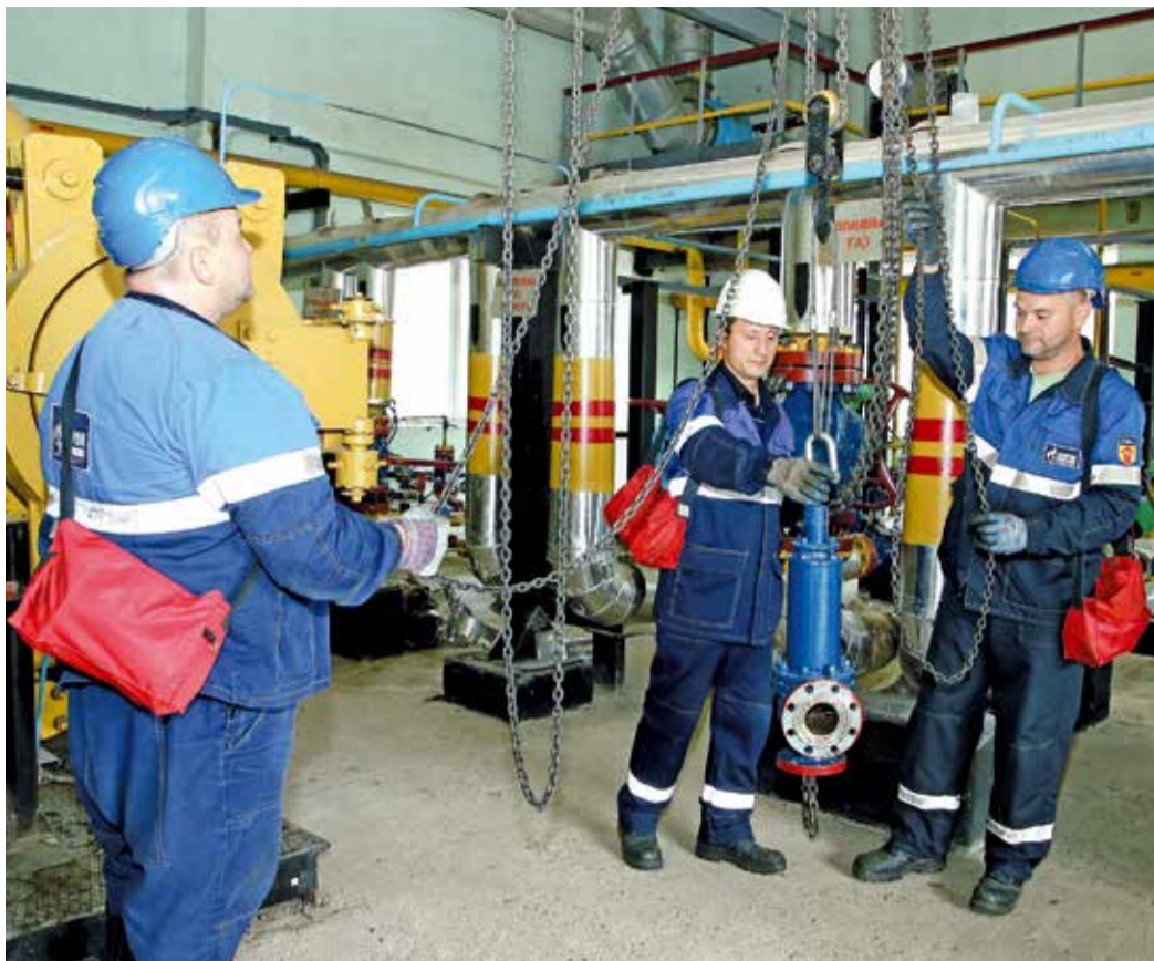
Машинисты технологических компрессоров Рустам Едиханов (слева), Владимир Кубасов (в центре) и слесарь по ремонту технологических установок Дмитрий Караулов демонтируют предохранительный клапан
