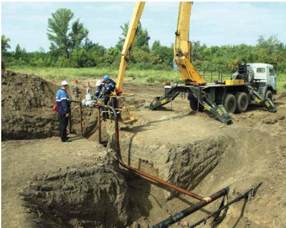
Чтобы смонтировать крановый узел на перемычке, соединившей скважину № 355 со шлейфом двух других, нужно обеспечить безопасный доступ к ней. Специально для этого подогнали гидроподъемник. Операторы по добыче нефти и газа Александр Абалмасов и Владимир Наймушин выполняют обтяжку фланцевых соединений. Работы контролирует заместитель начальника УКПГ № 14 Ярослав Назаров
