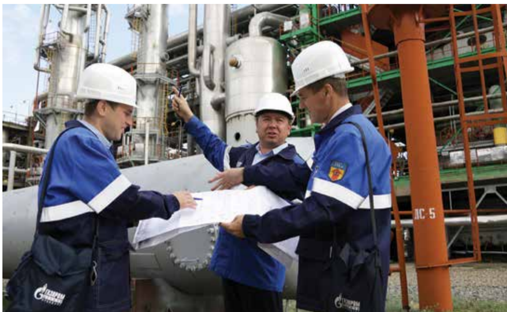
Инженеры обсуждают предстоящую замену колонны
