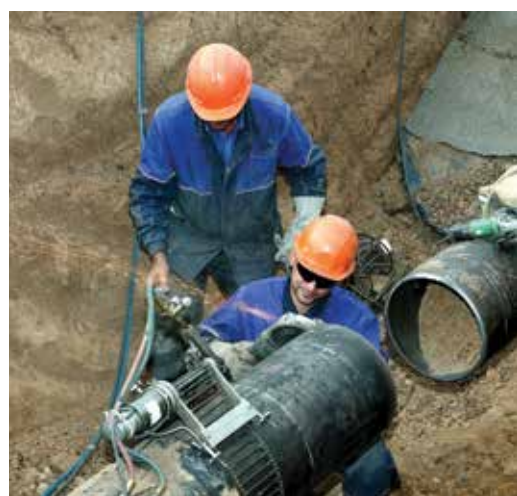
Подготовка кромки трубы
