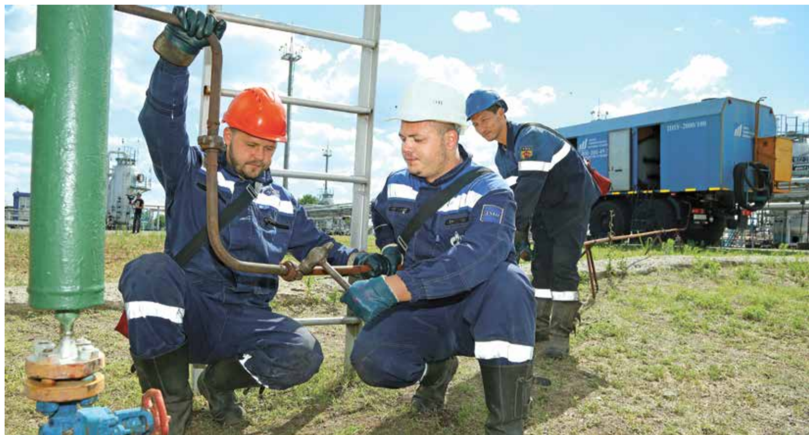
Идет подключение паровой передвижной установки к технологическому оборудованию
