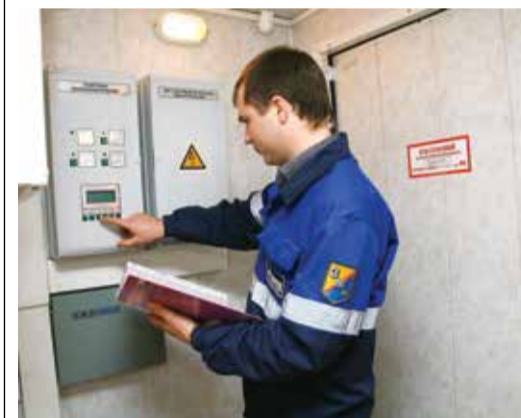
Идет настройка газоаналитического оборудования
