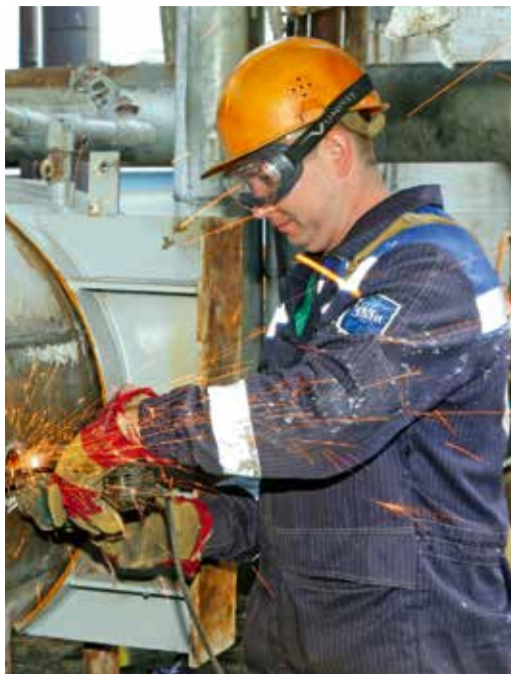
Слесарь технологических установок Ильшат Шарипов готовит емкость орошения для сварки штуцера
