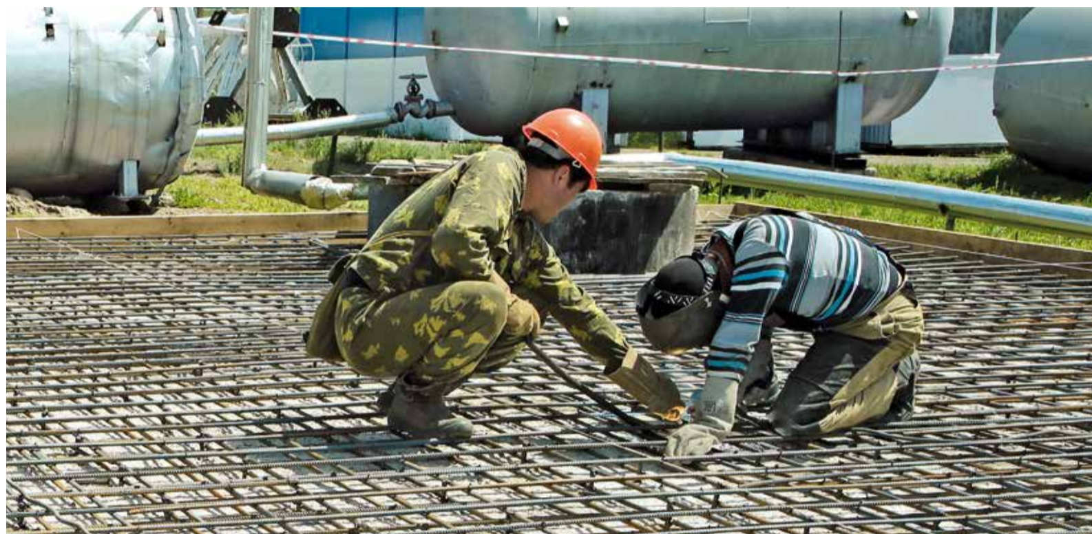
Ведется обвязка основы для будущего фундамента котельной
