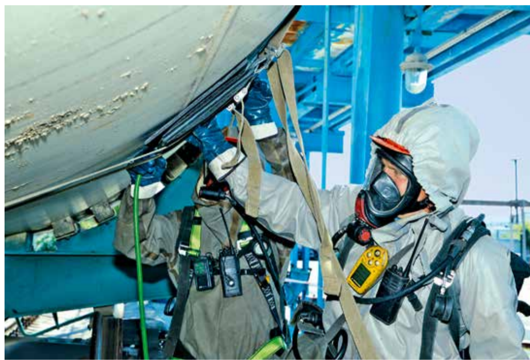
Идет установка магнитного пластыря
