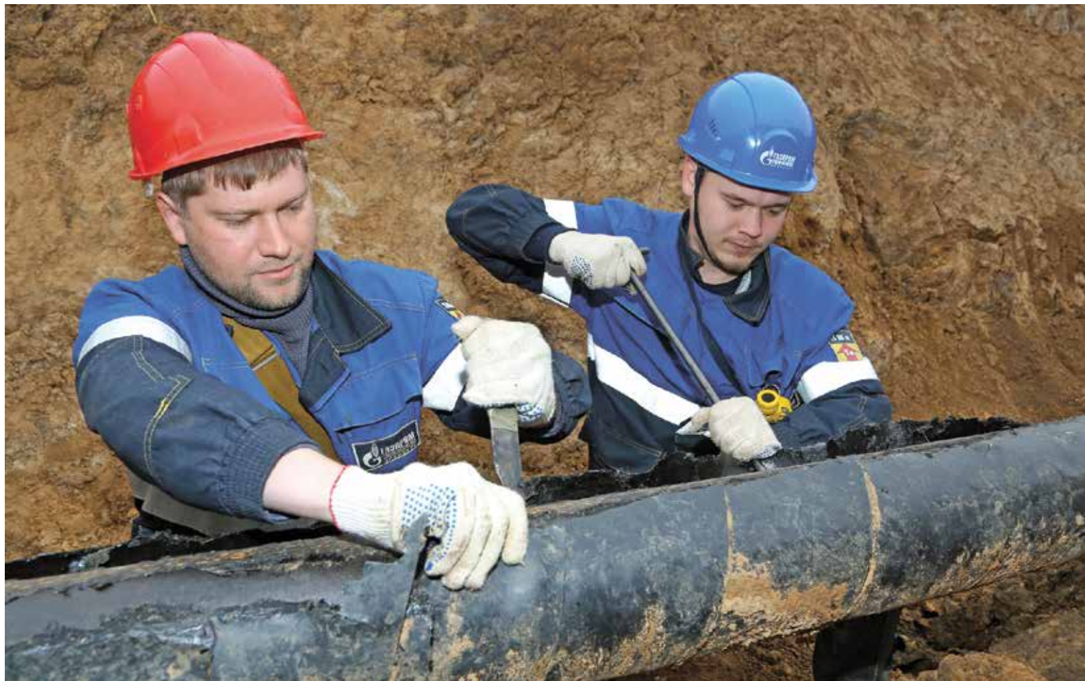
Трубопроводчики линейные Дмитрий Тухватуллин и Артем Михайлов вручную снимают старую изоляцию
