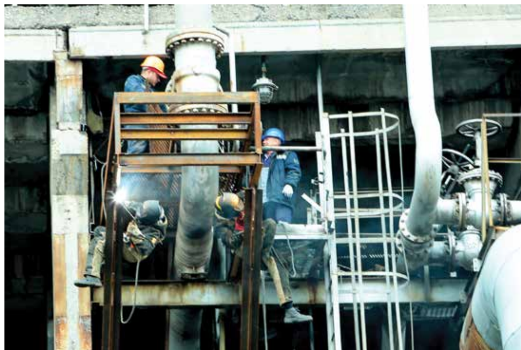
Подготовка к ремонту трубопровода
