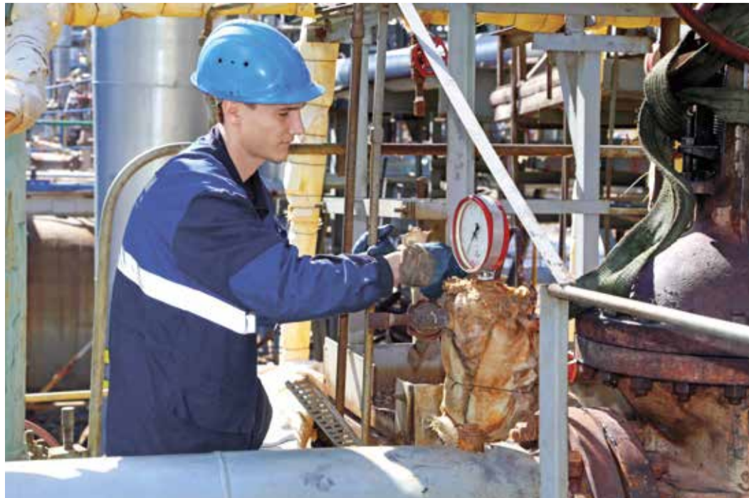
Оператор Вячеслав Меженин ведет установку манометра на трубопровод пара среднего давления
