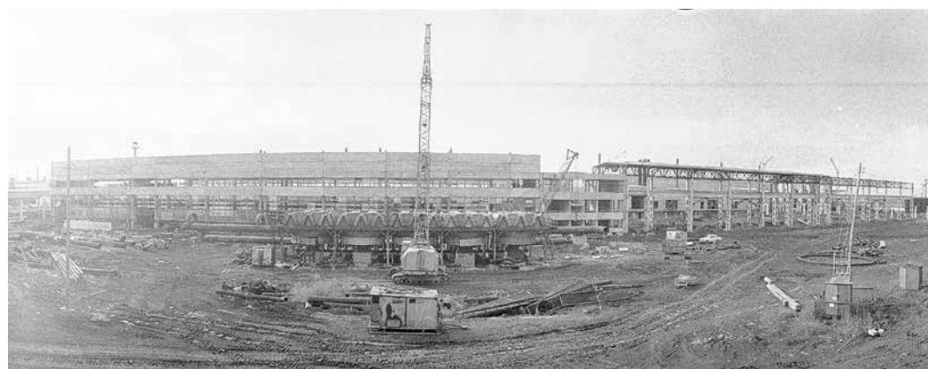
Ведется строительство 2-й очереди гелиевого завода. 1981 год
