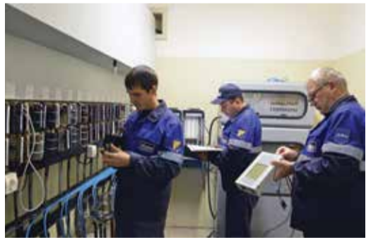
Идет обслуживание конечных устройств кабельных линий связи
