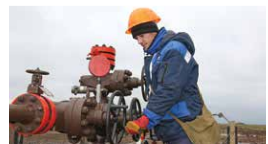
Проводится опрессовка насоса с регистрацией давления
