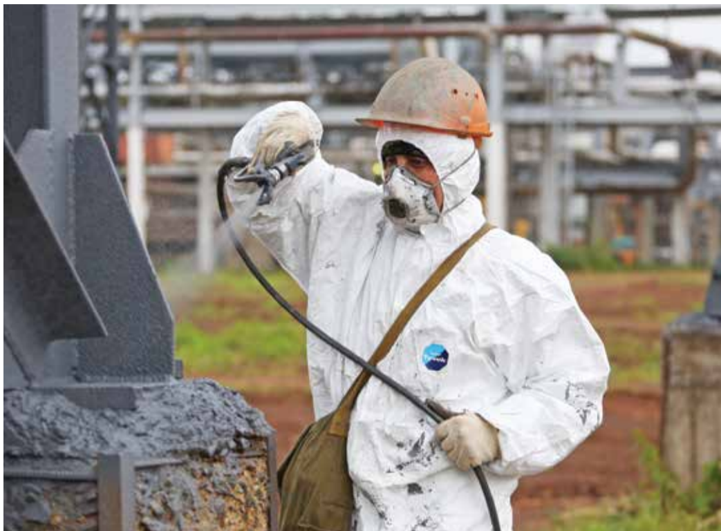
Нанесение огнезащитного слоя
