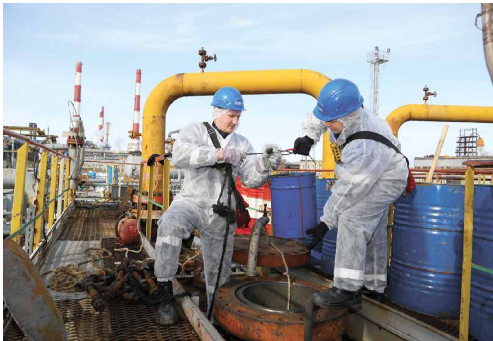
Операторы Евгений Федорук (слева) и Андрей Черныш ведут чистку сепаратора перед экспертизой промышленной безопасности
