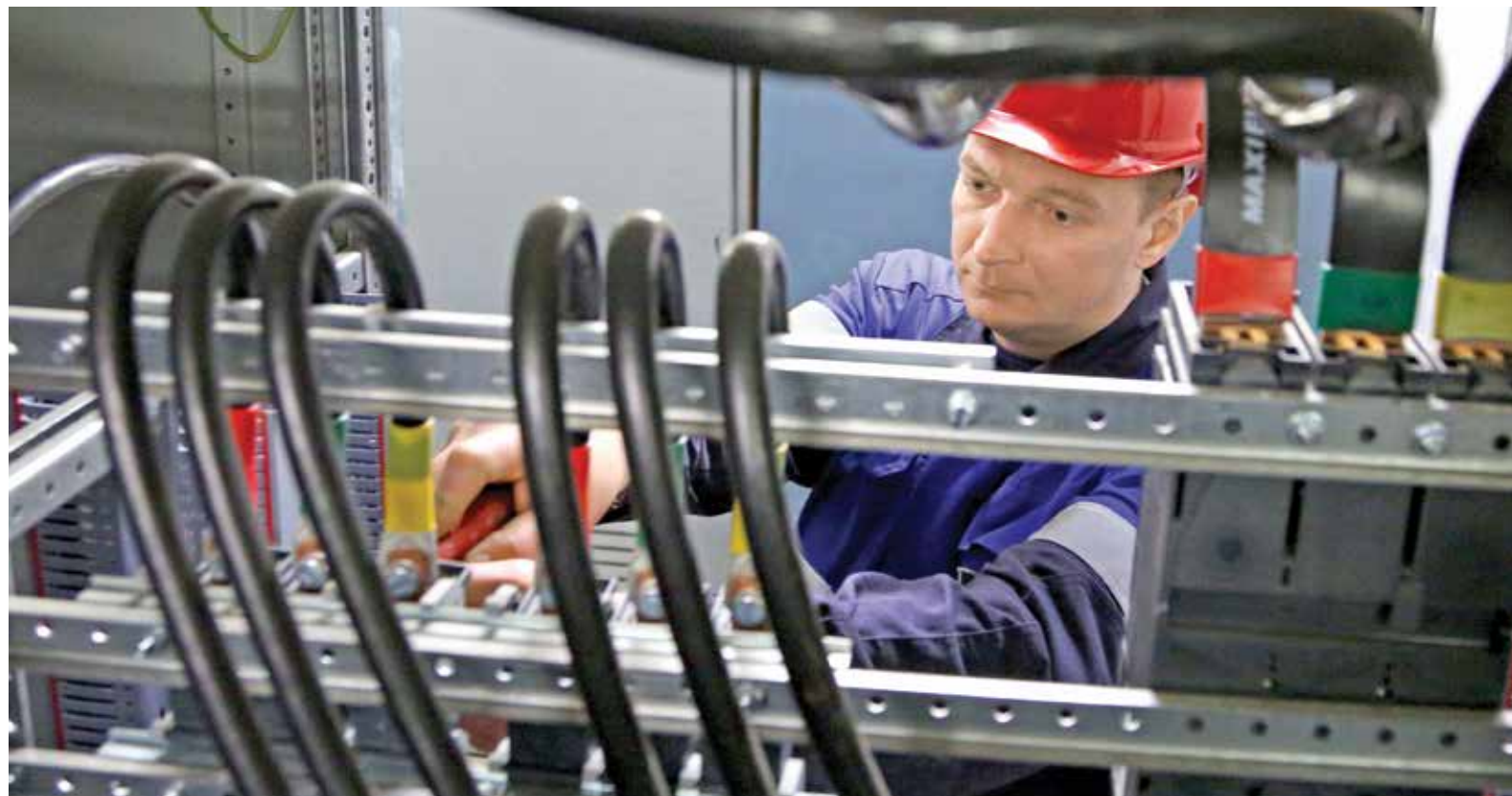
Электромонтер Александр Охрименко ведет проверку монтажа электрооборудования трансформаторной подстанции
