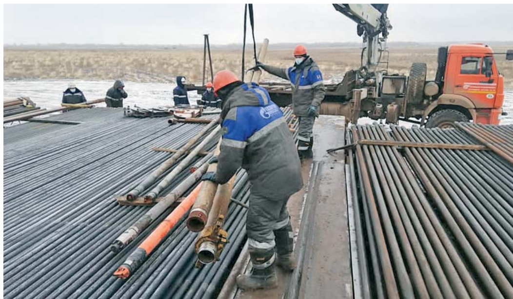
Разгрузка секций УЭЦН проводится с помощью крана-манипулятора
