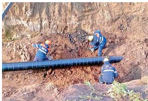
Представители подрядной организации выполняют изоляцию конденсатопровода
