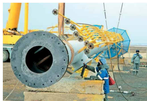
Выполнена замена обечайки и днища факела
