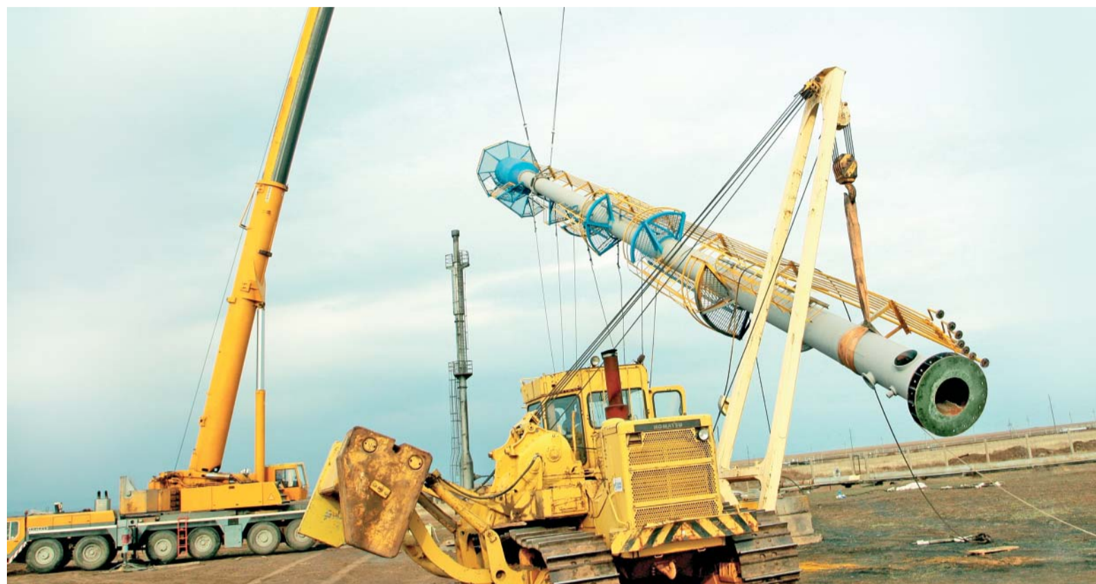
Монтаж отремонтированного факела
