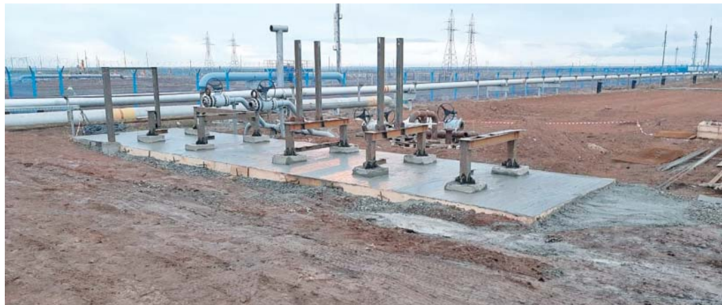
Узел учета жидких углеводородов с автоматическими расходомером и влагомером
