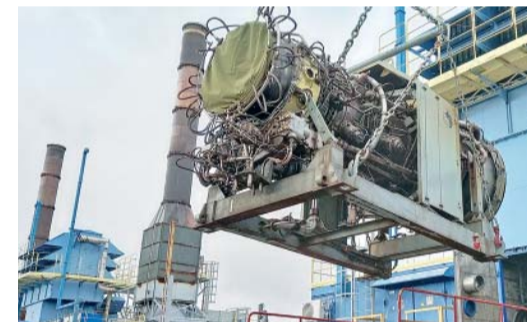
Демонтаж авиационного двигателя ГПА
